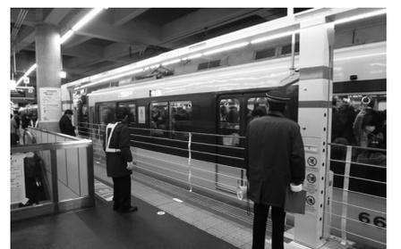
今年1月に近鉄大阪阿部野橋駅で試験的に設置された昇降ロープ式ホームドア(可動式ホーム柵)・4番線ホーム乗車側、中央の1両分
